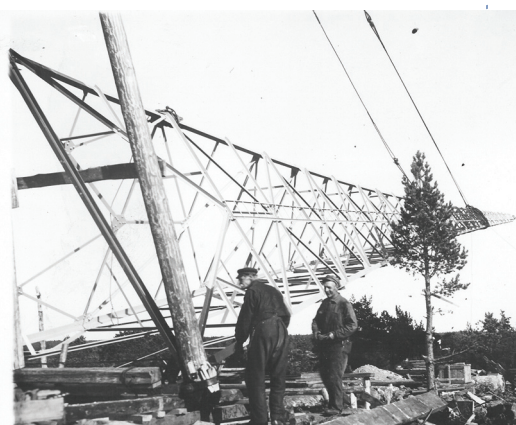
Manner valmisti ja pystytti Hangon radiomaston.
